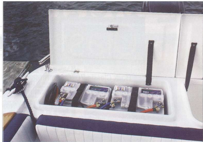
Die Batterieanlage ist gut zugänglich in einem Staufach im achterlichen Cockpit untergebracht, der Hauptschalter wurde griffgünstig in der Nähe des Steuerstuhls montiert
